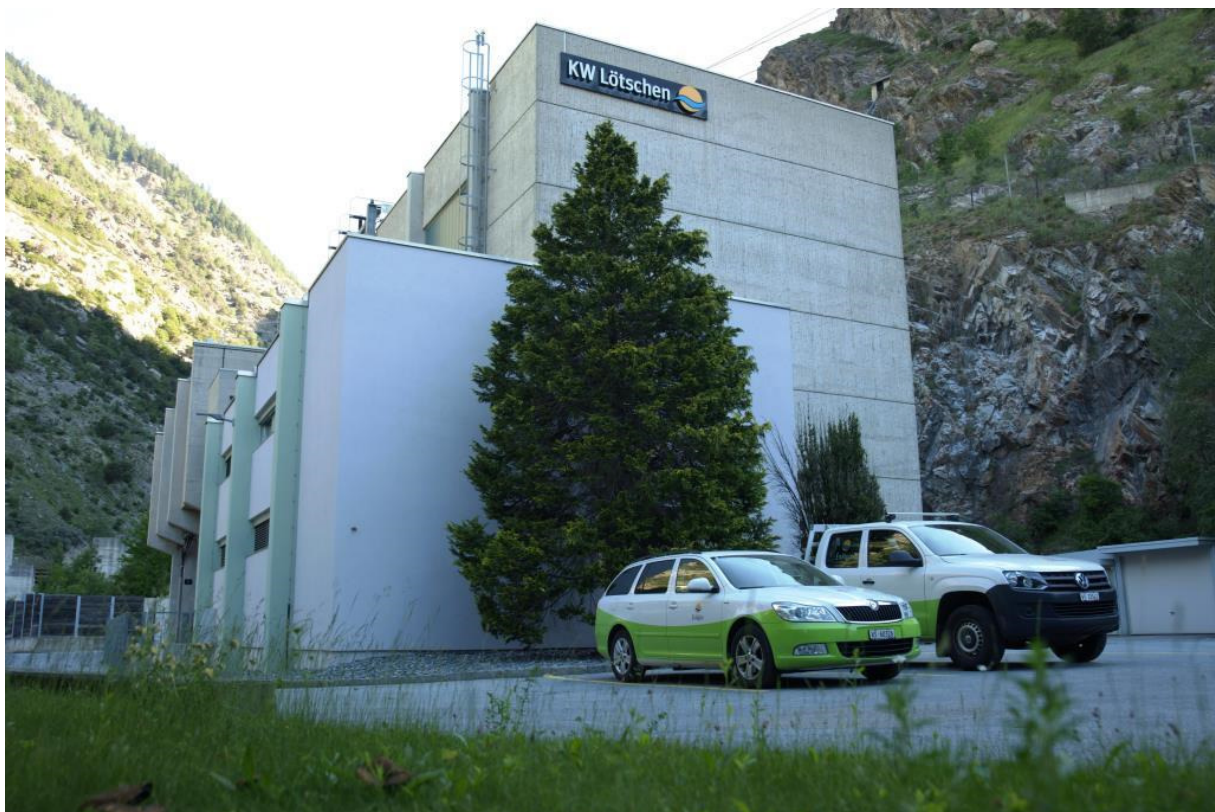
Kraftwerkzentrale Löttschen, Steg
