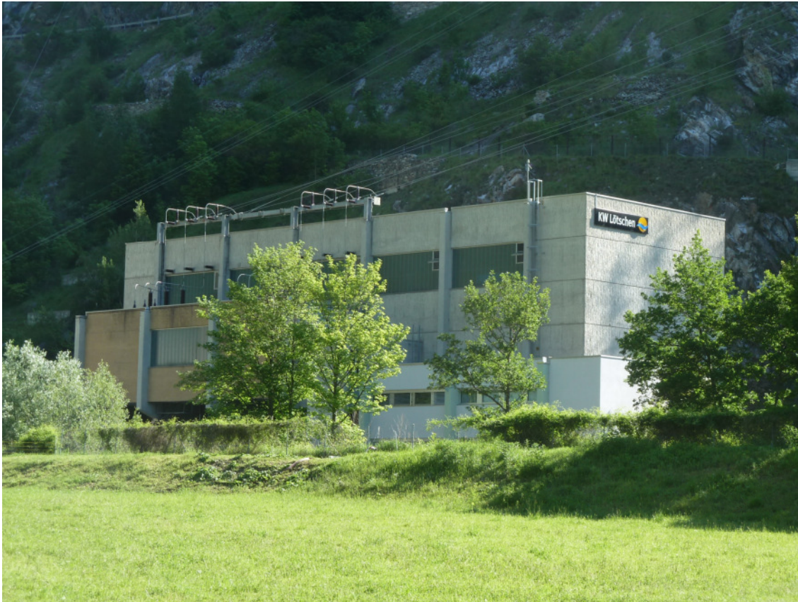
Kraftwerkzentrale Löttschen, Steg
